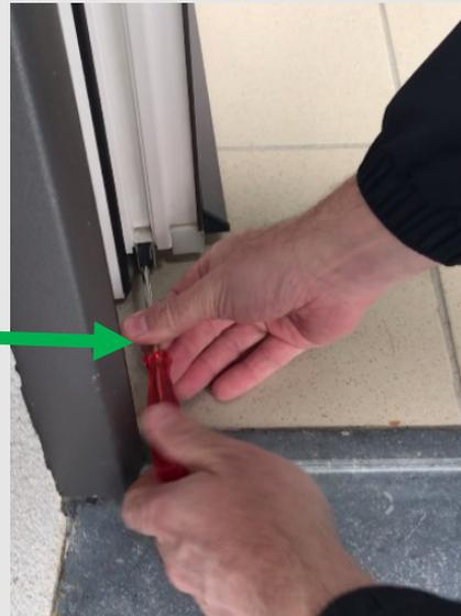
**2.** Pour descendre le joint de Kaltefeind, tourner le tournevis dans le **sens inverse des aiguilles d'une montre**.
