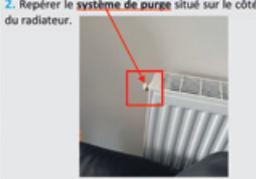
3. Dévisser avec la clé à purger pour évacuer l'air de la tuyauterie jusqu'à ce que de l'eau sorte. Pour ce faire, tourner la vis dans le sens inverse des aiguilles d'une montre.
