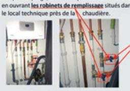
6. Vous entendez alors l'eau circuler dans les tuyaux. Patientez quelques secondes jusqu'à ce que le nanomètre affiche minimum 1 bar et maximum 3 bars. Ensuite, refermer les **robinets de remplissage** et attacher la clé à purger avec une ficelle aux tuyaux.
