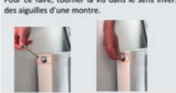
4. La présence d'eau indique qu'il n'y a plus d'air et que la purge est terminée. L'eau peut être marron mais ce n'est pas inquiétant. Lorsque l'eau s'écoule de façon continue, **refermez alors le purgeur** en revissant la vis délicatement dans le sens des aiguilles d'une montre.
