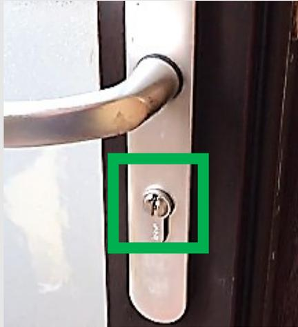
3. Repérer la **vis de fixation** du barillet à hauteur de la poignée dans l'entre-porte. Utiliser un tournevis pour la dévisser.
