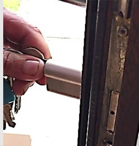
5. Mesurer la **distance de chaque côté** du barillet par rapport à l'emplacement du trou de la **vis de fixation**.
