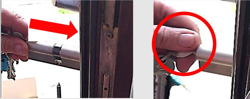
8. Visser la vis de fixation, à l'aide d'un tournevis, du barillet dans la porte.
