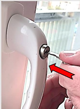
2. Tourner la clé dans le sens des aiguilles d'une montre.
