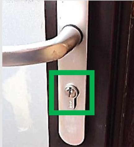
3. Repérer la **vis de fixation** du barillet à hauteur de la poignée dans l'entre-porte.
