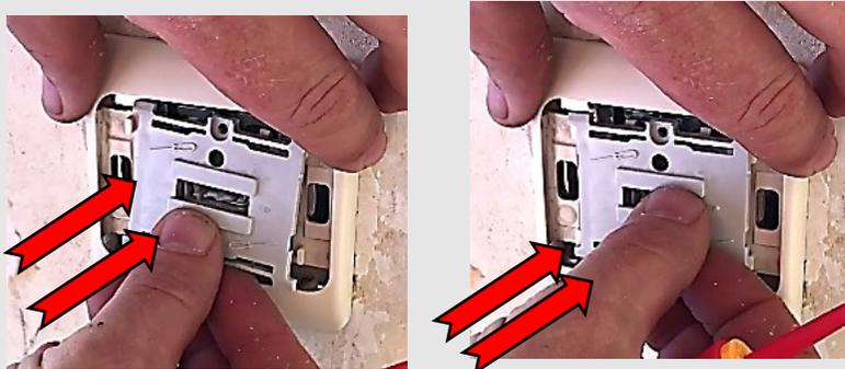
7. Clipser la partie mobile de l'interrupteur en plaçant l'encoche vers le bas.
