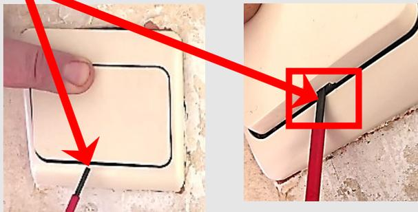
Introduire un petit tournevis dans l'encoche et **tirer pour déclipser** la partie mobile.
